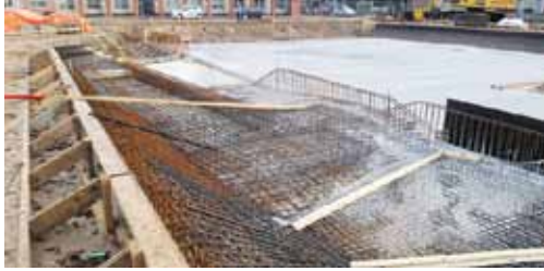
Şekil 11. Tiel'de inşa edilmekte olan su meydanı.
