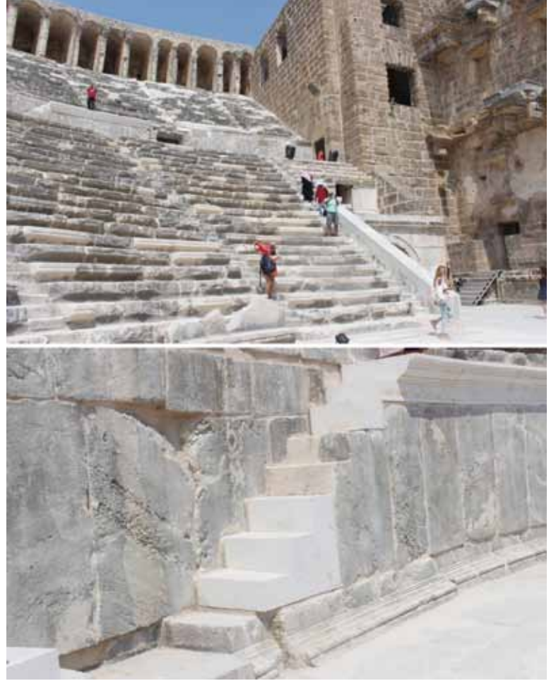
Resim 14. Aspendos Tiyatrosu tımlleme işlemleri sonrası. (Kevser Uzun, Ağustos 2015)
