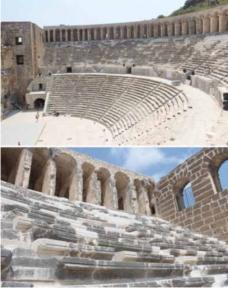
Resim 13. Aspendos Tiyatrosu tımlleme işlemleri sonrası. (Kevser Uzun, Ağustos 2015)
