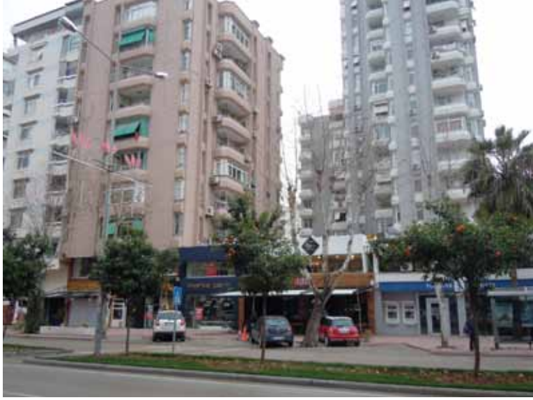
Resim 3. Kurtuluş mahallesinde apartman blokları ve altındaki alışveriş mekânları. (10)
