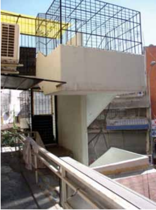
Resim 14-16. Pres tuğla kaplı cephe ve brüt beton merdiven.
