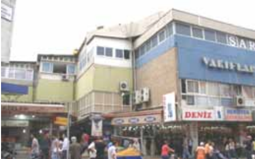
Resim 17. Yapının günümüzde ana cephesi.
