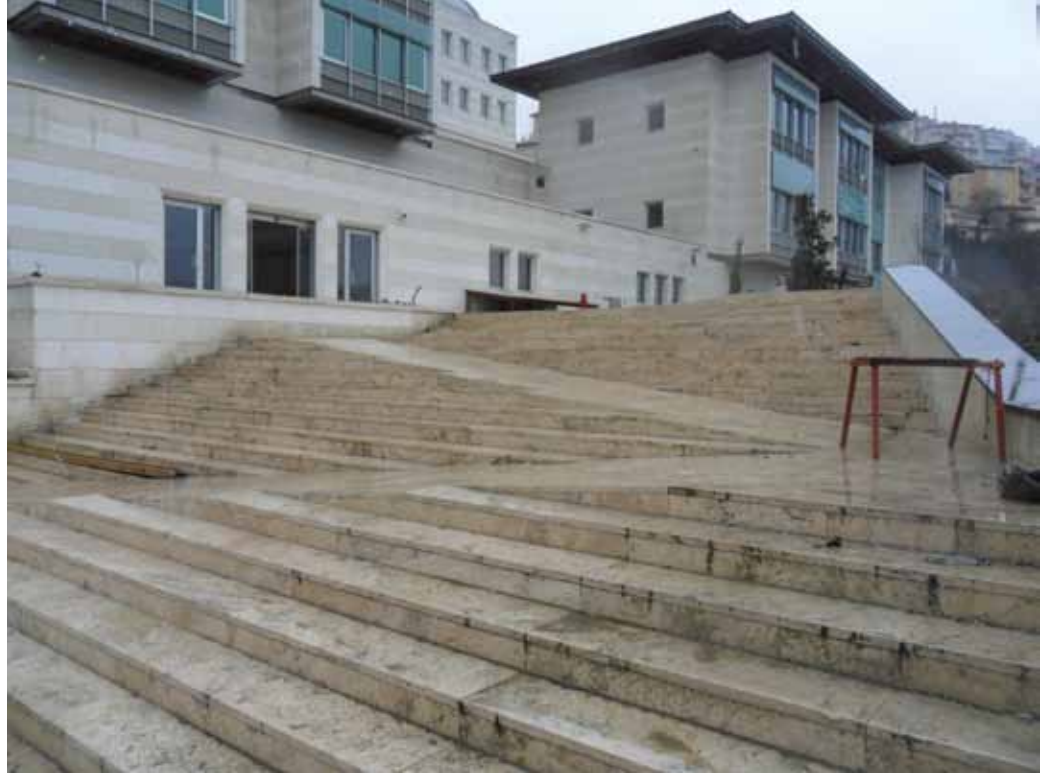
Fotoğraf 4. Rampa-merdiven karışımı bu tür çözümler, tekerlekli sandalye kullanan, görmeyen, yaşlı, çocuk, kısacası herkes için tehlikeli ve erişilmezdir.
