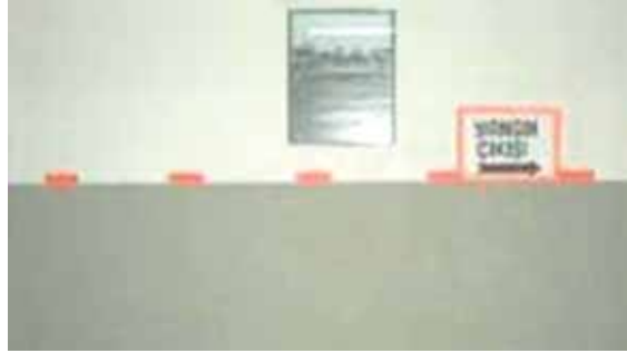
Şekil 2. Görme engelliler için koridorun algılanmasını sağlayan renkli bantlar ve görme engelli sırası.
