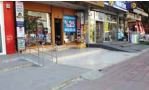
Şekil 8. Bülent Angın Bulvarı Bina Girişleri.
