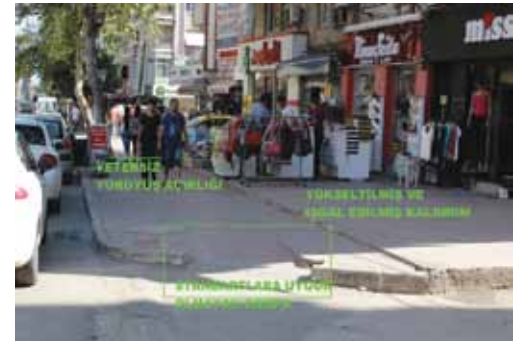
Şekil 4. Bülent Angın Bulvarı Kaldırım ve Kaldırım Kenarı Rampaları.
