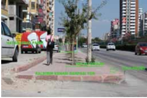
Şekil 2. Turgut Özal Bulvarı Kaldırım ve Kaldırım Kenarı Rampaları.
