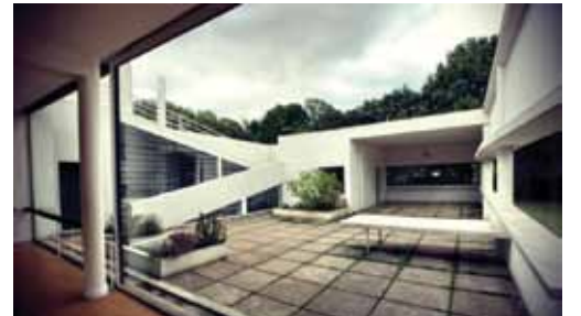
Resim 6. Villa Savoye (1929) terastan görünüm.
