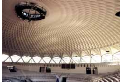
Resim 9-10. Palazzetto Dello Sport (1957) kabuk strüktürü.
