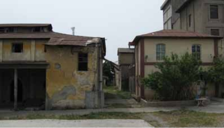
Şekil 4a. Çırcırlama ünitesi ve idari bina.
