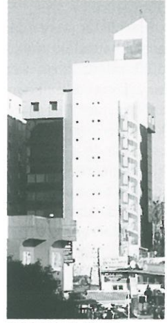
Demirbank Binasi (D. Saban)
