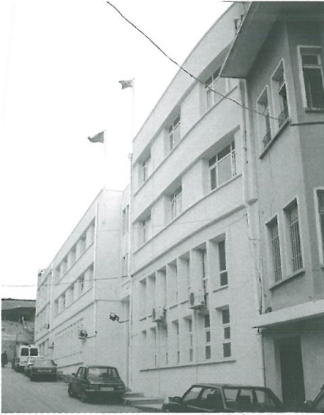
1964'te inşa edilen ilave bina (D. Saban)
