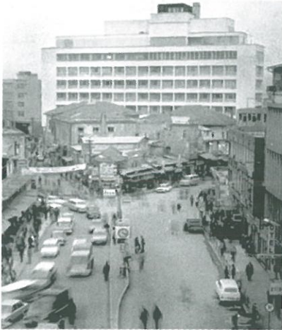
1979'da Defterdarlık Binası (M. Baltacı Arşivi)
