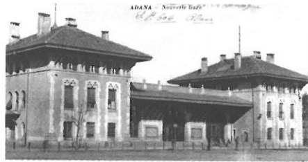
Gar binasının özgün hali (Başgelen, 1998)
