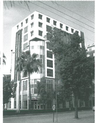
Vakıfbank Binasi (D. Saban)
