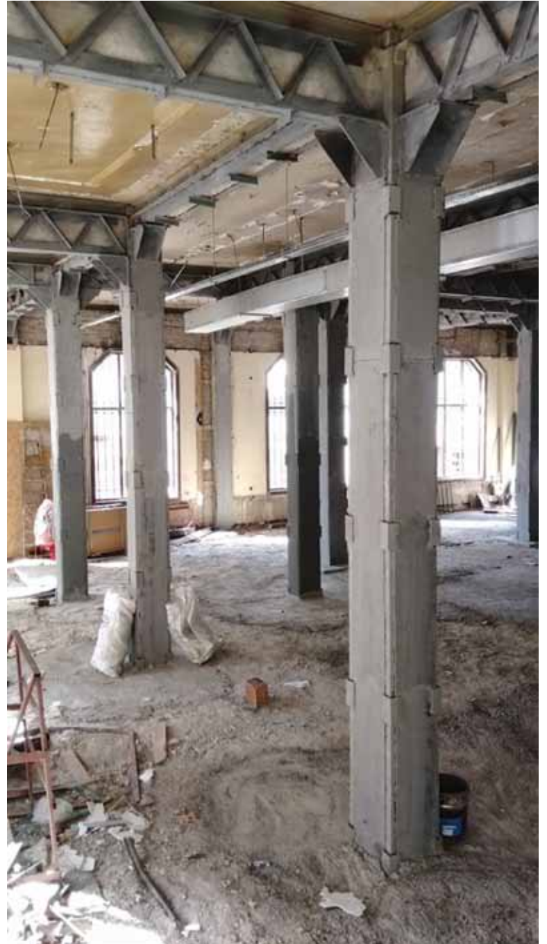
Resim 34. Yapının zemin katının restorasyonu esnasındaki güçlendirme çalışmaları.
