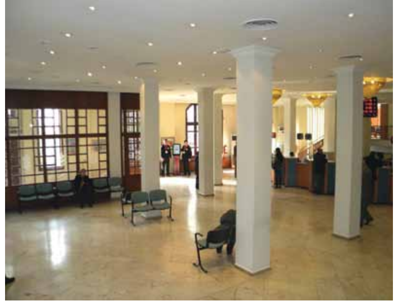
Resim 33. Yapının zemin katının devam eden restorasyondan önceki durumu.
