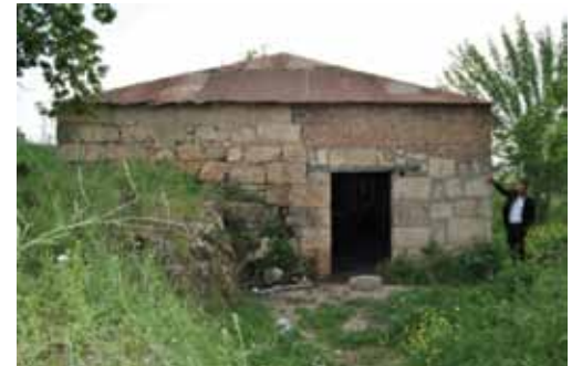
Resim 2. Değirmen Doğu Cephesi.
