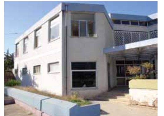
Resim 5. Yapıda Konaklama Ünitelerinin Bulunduğu Güney Cepheden Görünüm.
