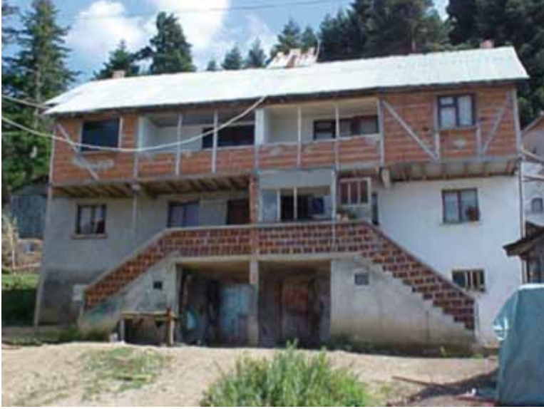
Resim 4-5. Abant Samat Yaylasındaki Kaçak Yapılaşmalar.
