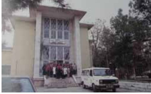
Şekil 13. Otelin giriş cephesi. Fotoğraf yapının Adana Büyük Şehir Belediyesi Sağlık Merkezi olarak kullanıldığı dönemden (1973 İl Yıllığı).
