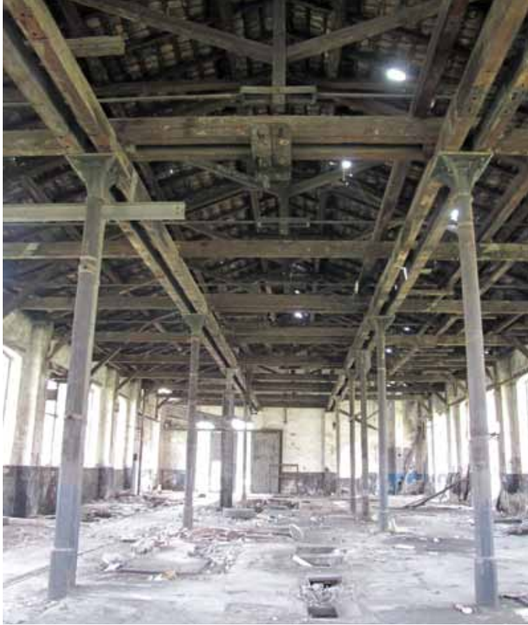
Fotoğraf 6. Tornaj Atölyesi yapısından iç görünüş. Çelik gergili ahşap makaslar ve bunlardan bağımsız pik kolonlar ile ahşap kirişler görülmektedir.
