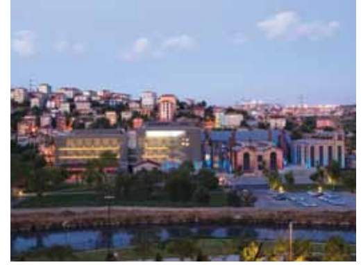
Resim 9. Santral İstanbul olarak yeniden işlevlendirilen Silahtarağa Elektrik Santrali, İstanbul (Köksal, 2005).
