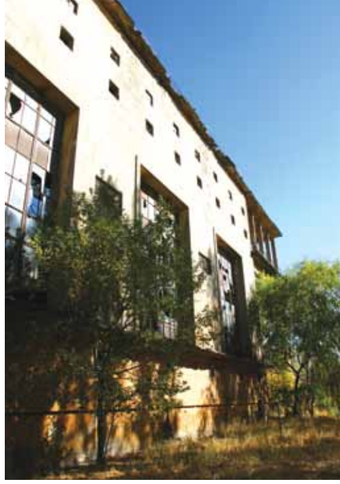
Şekil 11. Sümerbank Kayseri Bez Fabrikası Elektrik Santrali.
