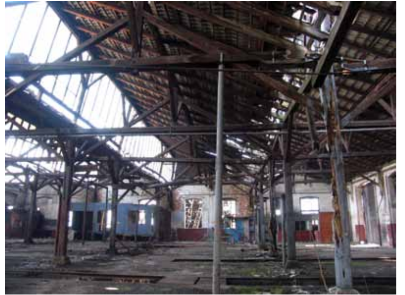
Fotoğraf 5. Vagonaj (Vagon Bakım ve Onarım Atölyesi) yapısı iç görünüşü. Yığma sistemde inşa edilmiş yapının çatısı ahşap konstrüksiyon şet çatıdır. Yapının duvarları günümüzde varlığını korumaktadır ancak çatısı çökmüştür.
