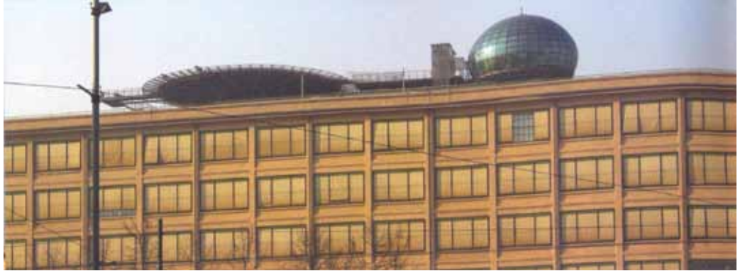
Kolonları, kirişleri ve döşemeleriyle zamanının ilk prekast binasının cepheye yansıyan yapısal özellikleri olduğu gibi korunmuş. Foto: Torino, Always on The Move, Citta di Torino, sf:14.
