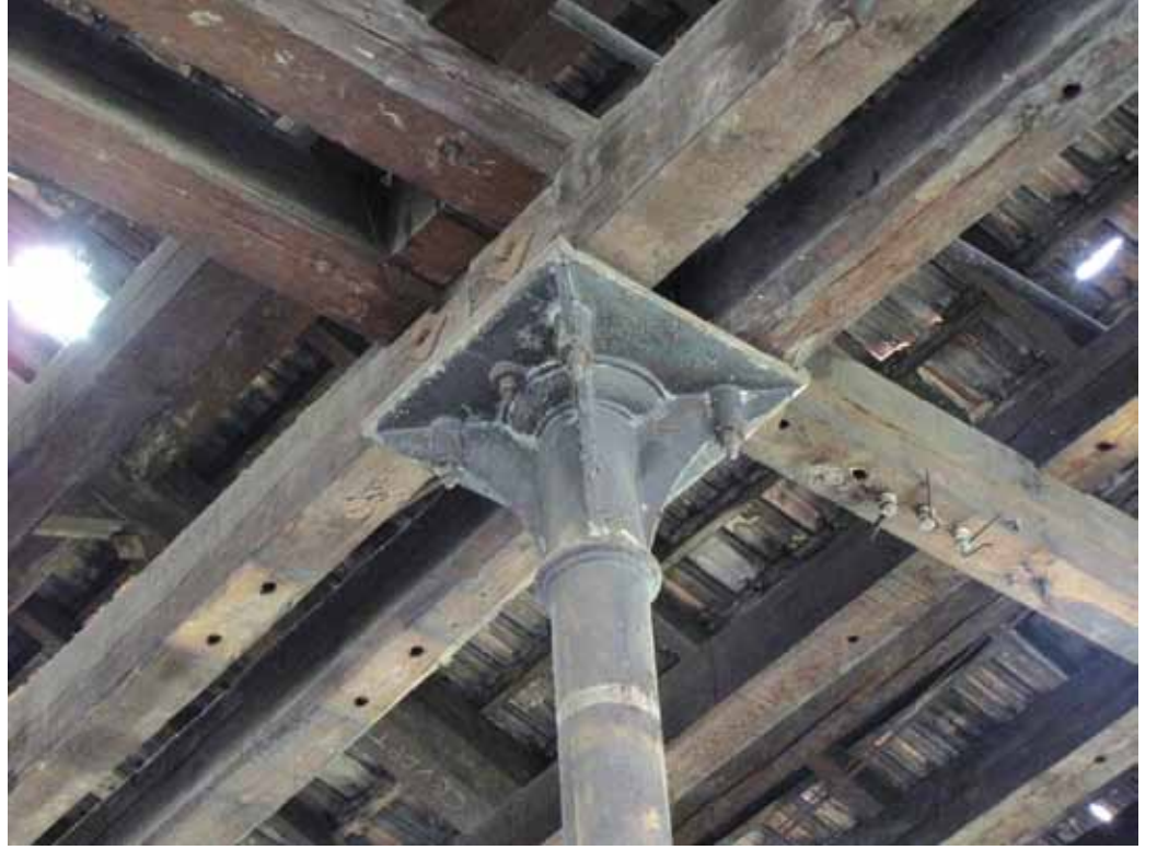
Fotoğraf 9. Tornaj Atölyesi yapısından iç görünüş. Pik kolon, başlığı ve taşıdığı ahşap kirişler.
