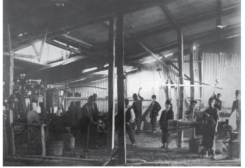
Fotoğraf 3. 1800'lerin sonunda Vagonlar yurt dışından eskisi gibi bir bütün halinde değil, parçalı bir şekilde İstanbul'a getirilerek Yedikule'de kurulan atölyelerde monte edilmiştir (Kaynak: Ankara Demiryolu Müzesi Fotoğraf Albümleri).
