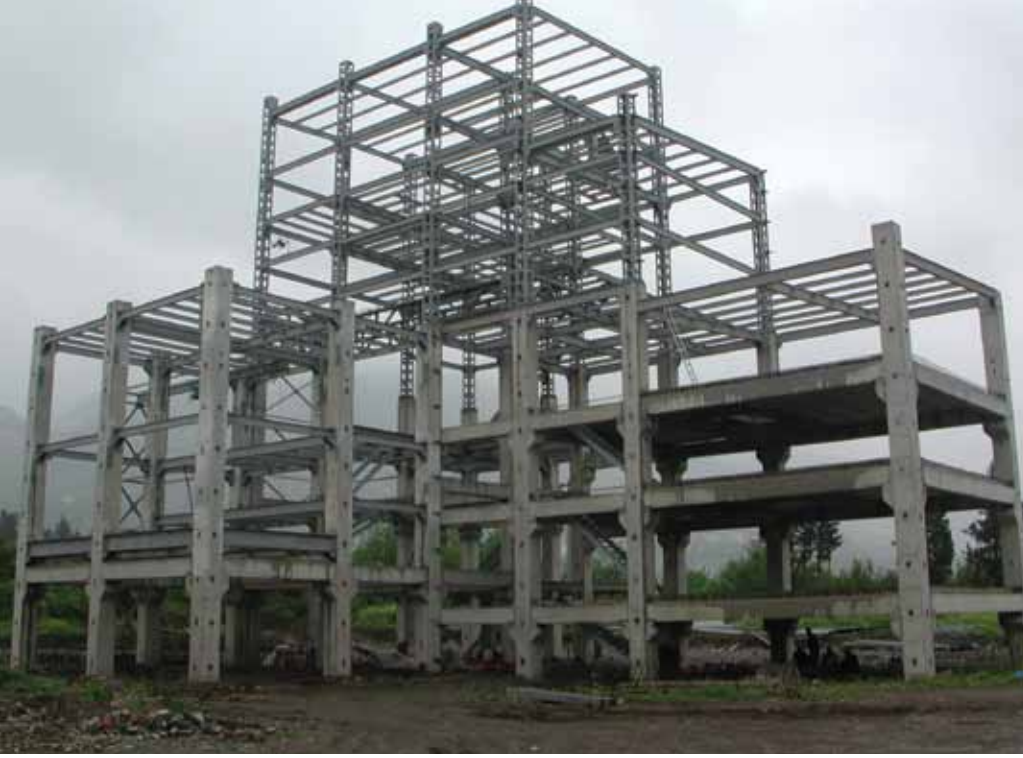
Resim 3. BA Prefabrik + Çelik Sanayi Yapısı.
