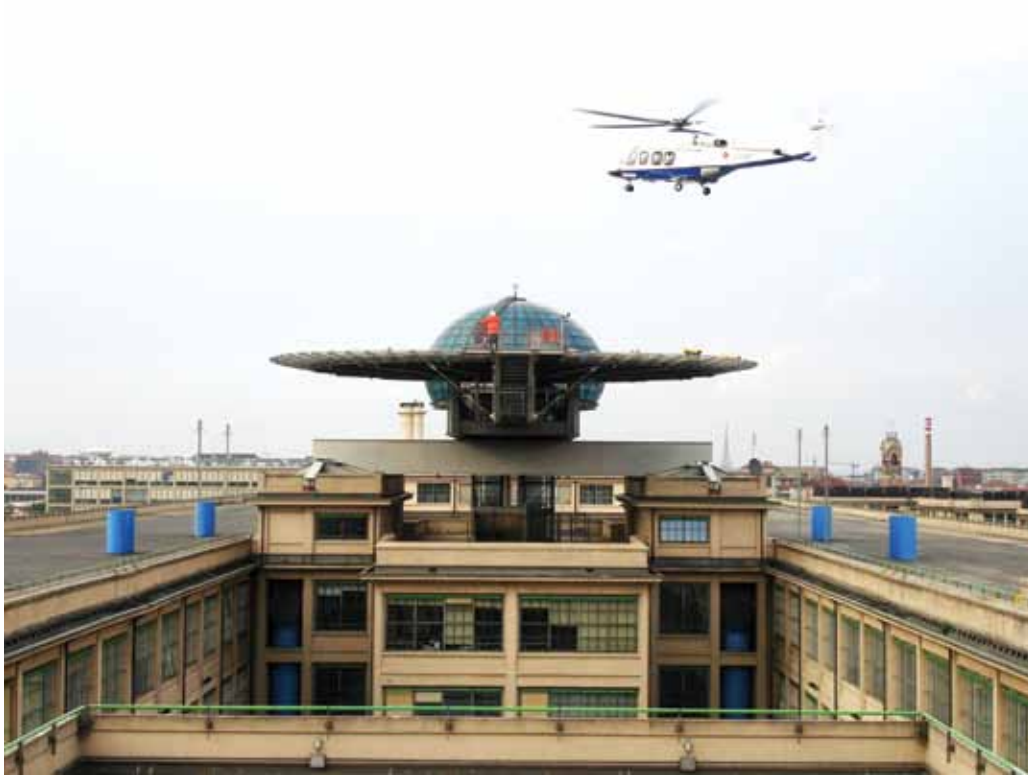
Çatıya yapılan çelik strüktür eklenti. Foto: Müge Cengizkan.
