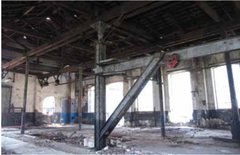
Fotoğraf 7. Tornaj Atölyesi yapısından içi görünüş. Pik kolona monte edilmiş vinç.
