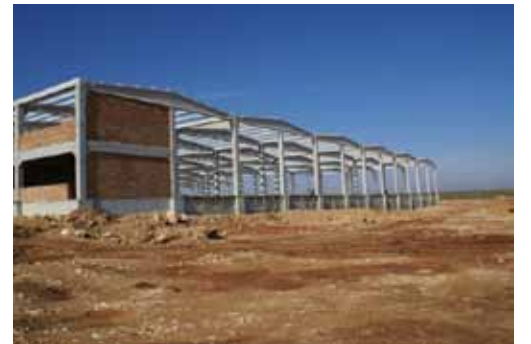
Resim 2. Betonarme Prefabrik Sanayi Yapısı.
