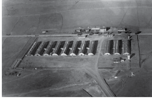
Şekil 5. Uçak Fabrikası Hangarları, 1927 (Kayseri 2. Hava İkmal ve Bakım Merkezi Arşivi).
