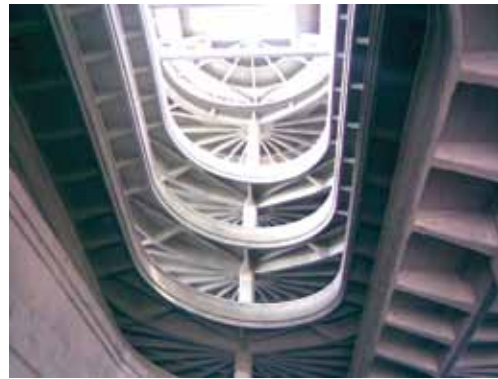
Çatıya çıkan rampa. Foto: Rüksan Tuna.
