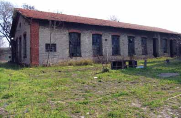
Fotoğraf 4. Tornaj Atölyesi. Yığma sistemde inşa edilmiş yapının çatı konstrüksiyonu çelik çubuk gergili ahşap makaslardan oluşmaktadır. Yapının içinde; taşıyıcı sisteminden bağımsız olan, pik kolonlardan ve ahşap kirişlerden oluşan ikinci bir sistem bulunmaktadır ve atölyenin işlevi için gerekli mekanik aksamın taşıyıcısı olarak kullanılmıştır (kreyn, vinç, tesisat vb.) Yapı kompleks içinde özgünlüğünü ve bütünlüğünü günümüze dek koruyabilen tek yapıdır.
