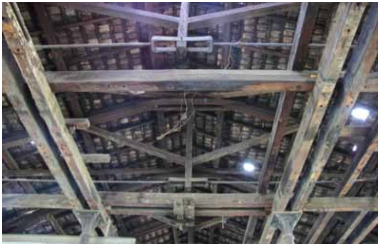
Fotoğraf 8. Tornaj Atölyesi yapısından iç görünüş. Çelik gergili ahşap makas detayları.
