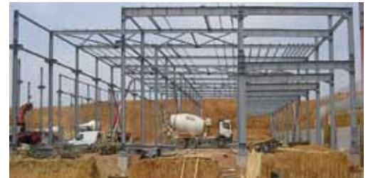
Resim 1. Çelik Konstrüksiyon Sanayi Yapısı.
