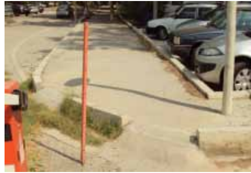
Konservatuar Bölümü yol ayrımında otopark kaldırım birleşim yerinde rampa düzenlemesi.
