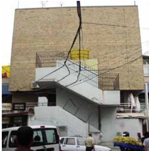
Resim 25. Batı Cephesinde Brüt Beton Merdiven (Fotoğraf: O. Erman)
