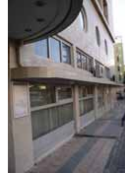
Resim 21. Kuzey Cephede Zemin ve Asma Katta Ofisler ve Betonarme Saçak (Fotoğraf: O. Erman)
