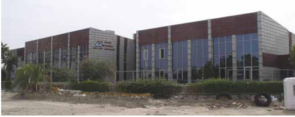
Resim 38. Halk Kütüphanesi (Kuzey) Cephesi
