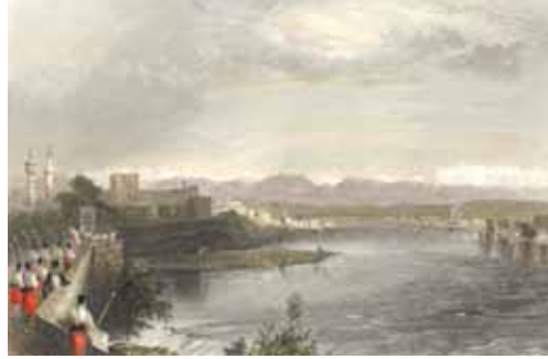
Taşköprü ve Tepebağ
