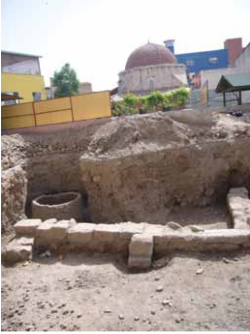
Çevikkuvvet Binası Arkası Hamam Su Yolu
