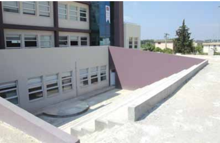
Okul Öncesi Eğitim Binası Güneybatı Cephesi.
