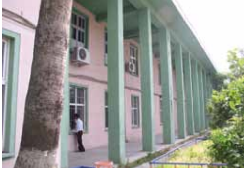
Resim 16. Motor Meslek Lisesi, ana bina kolonadlı cephe.
