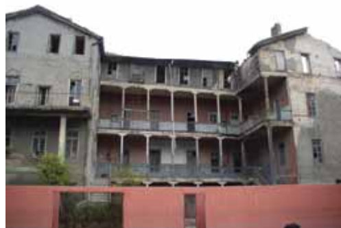
Resim 1. Tepebağ Ortaokulu avlu cephesi (batı cephesi).
