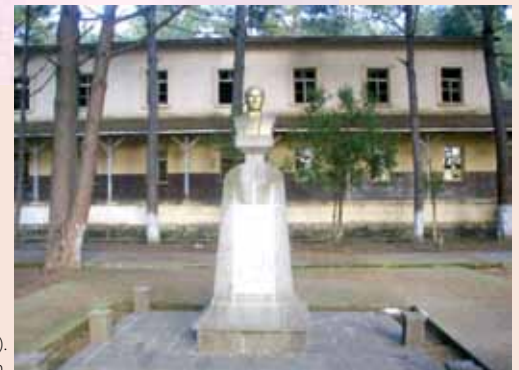
II. Bina (okul müzesi). Ön cepheden görünüm.
