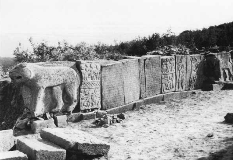
Karatepe Kuzey kapısı kabartma ve yazıtları. İlk düzenleme aşamasında, koruma çatısı yapılmadan önce.
