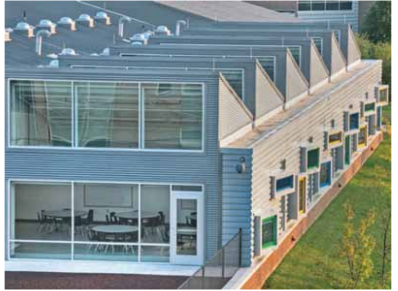
Testere dişli çatı dilimleri kuzey pencereleri ve sınıflara günışığı sağlayan güneş tüplerini barındırıyor. Fotoğraflar: VMDO Architects/Prakash Patel.
