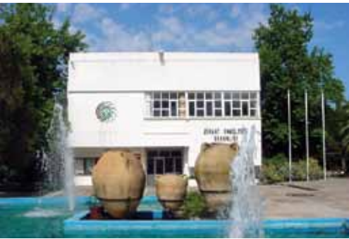
Resim 25. Ziraat Fakültesi Dekanlık Binası.
