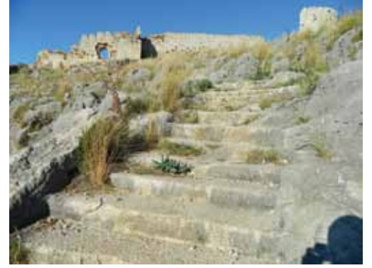
Resim 10. Merdivenden Güney Surları.
