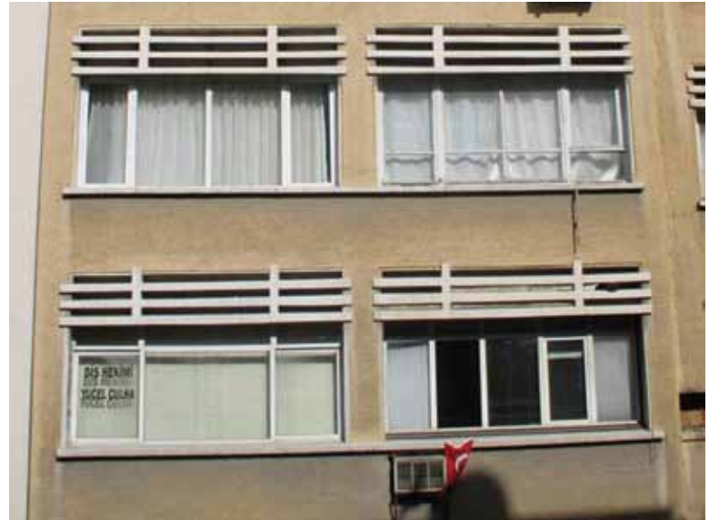
Resim 13. Güney Cephede Yer Alan Beton Güneş Kırıcılar.
