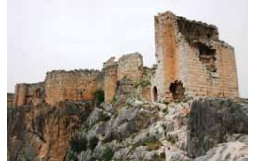
Resim 21. Donjon Kule, İki Farklı Onarımı.
