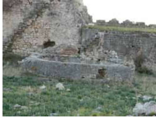
Resim 9. T Binası ve Önündeki Yuvarlak Memluklu Yapısı.
