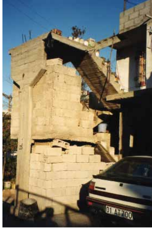
Resim 6. Dervişler mahallesinde sonradan eklenen üst kata çıkan merdiven. Bu tür merdivenlerin, "taşıyıcı sistemi" pek kolay kavranamıyor.
