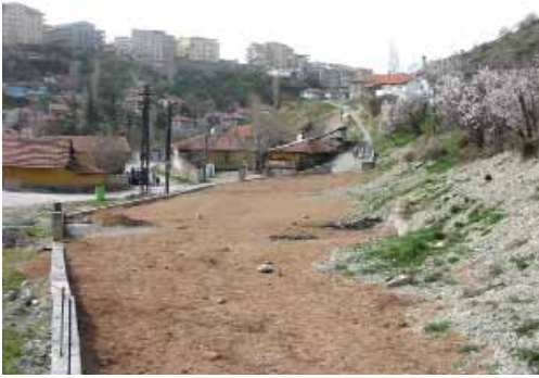
Resim 6a. Araziye sınır duvarı çekilmesi, 2006.
