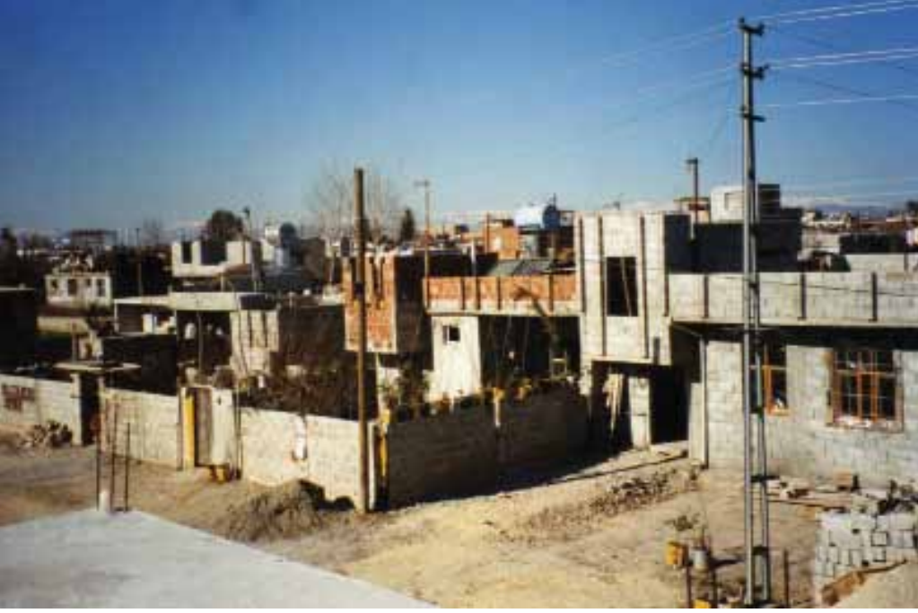
Resim 3. 19 Mayıs mahallesinde yeni gelişme alanları. Olanağı daha fazla olanlar, başlangıçta konutun birkaç katını kaba inşaat olarak tamamlayıp, bir katına yerleşiyor; tamamlanmamış katın duvarları da, çatıda bir tür korkuluk oluşturmak üzere, pencere parapet düzeyine dek yükseltiliyor.
