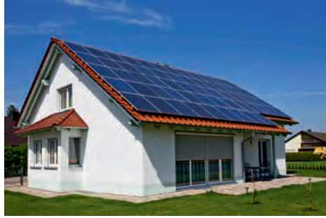
Şekil 6. a) Binaya sonradan ilave FV sistem
