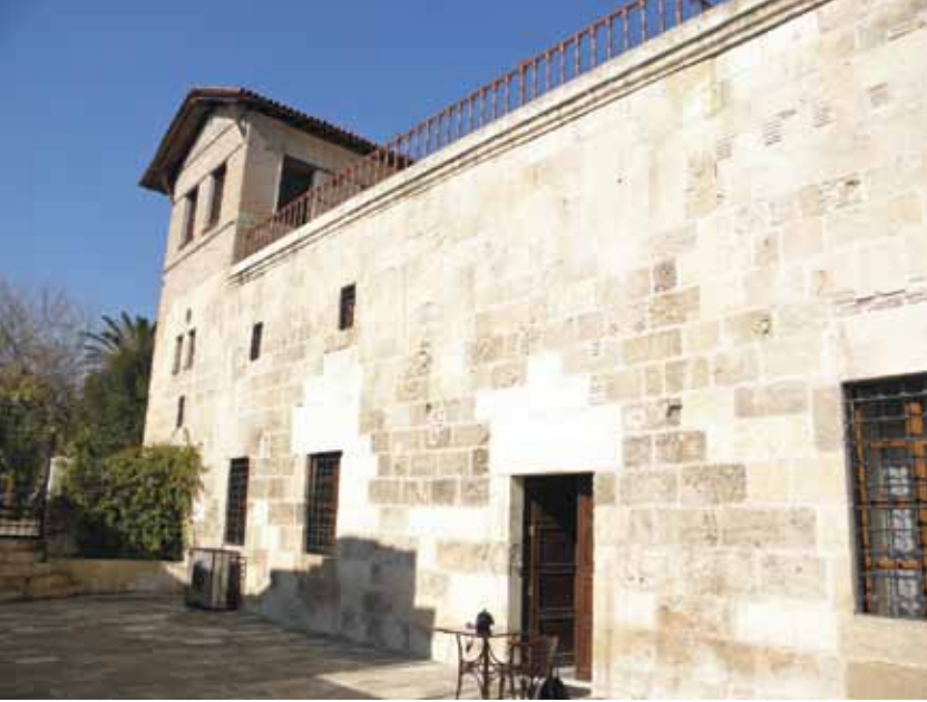
Resim 6. Restorasyon Sonrası Konak 1
