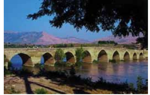
Resim 4. Misis Köprüsü Adana
