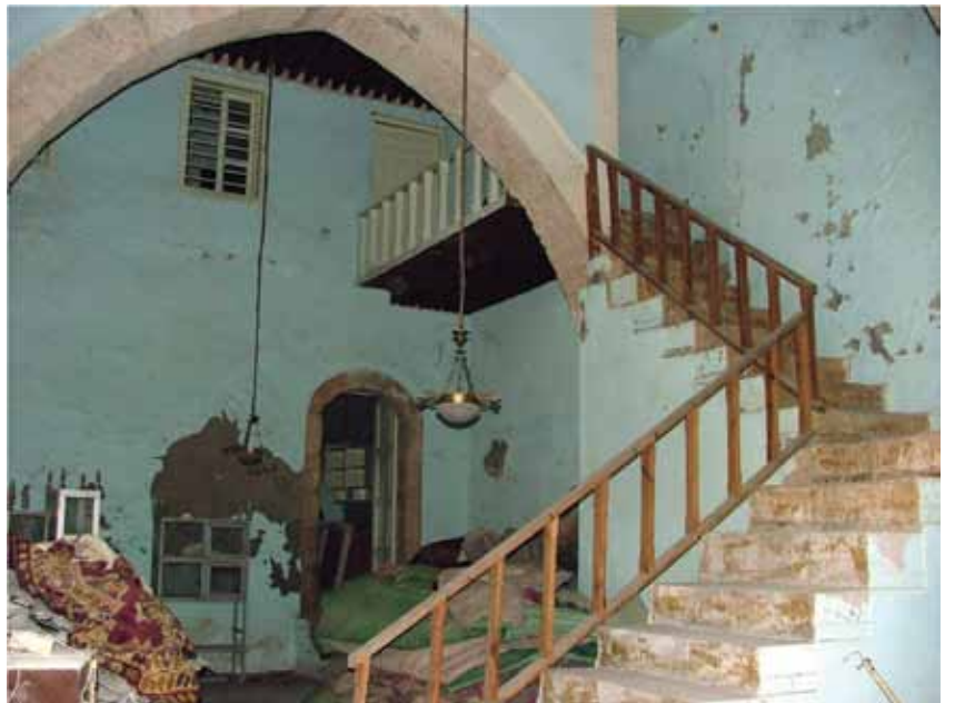
Resim 4. Restorasyon Öncesinde Konak İç Mekan
