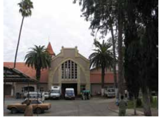
Resim 1. Mezbaha giriş cephesi (Akar, 2005)
