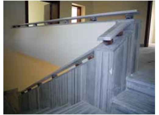
Resim 9a-b. Restore edilen ve özgün mermer küpeşterleri monte edilen merdiven (foto: Oğuz Ergeç)
