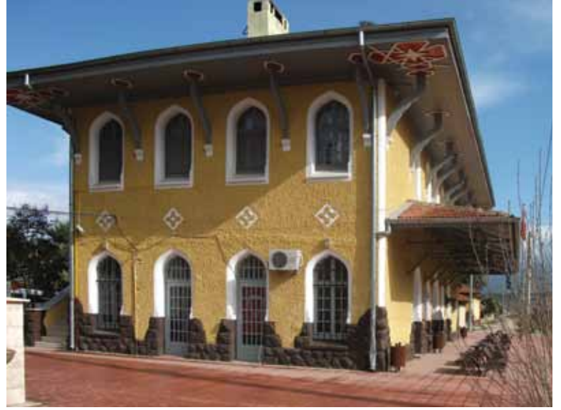
Resim 11. İstasyon Binası (Fotoğraf: T. Hakan Önal)
