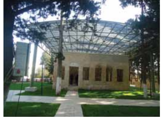
Resim 6. Batı Cephe Onarım Sonrası
