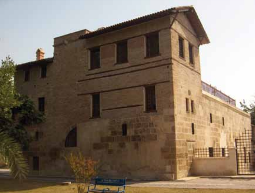
Resim 7. Restorasyon Sonrası Konak 2
