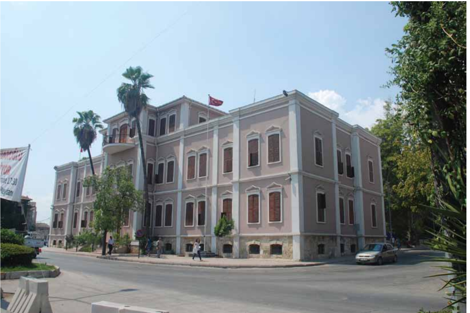
Adana Hükümet Konağı. Fotoğraf: Vedat Zöhre
