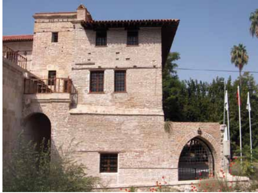
Resim 8. Restorasyon Sonrası Konak 3
