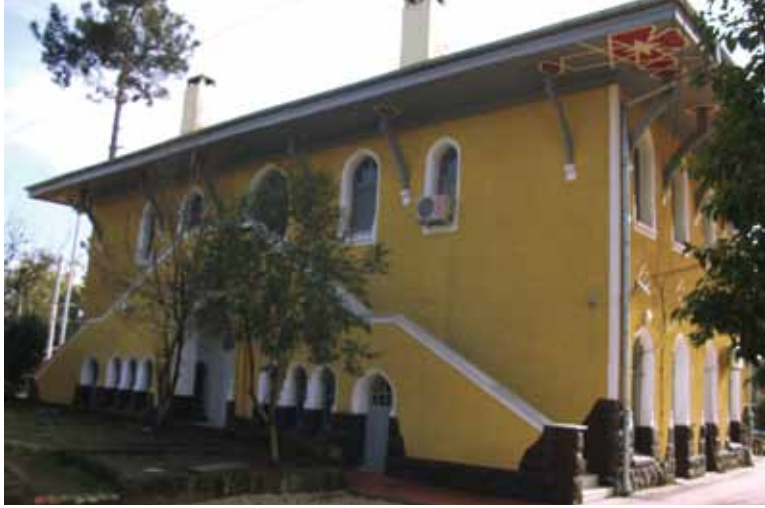
Resim 14. İstasyon Binası (Fotoğraf: T. Hakan Önal)
