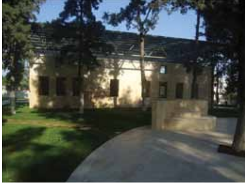
Resim 7. Güney Cephe Onarım Sonrası
