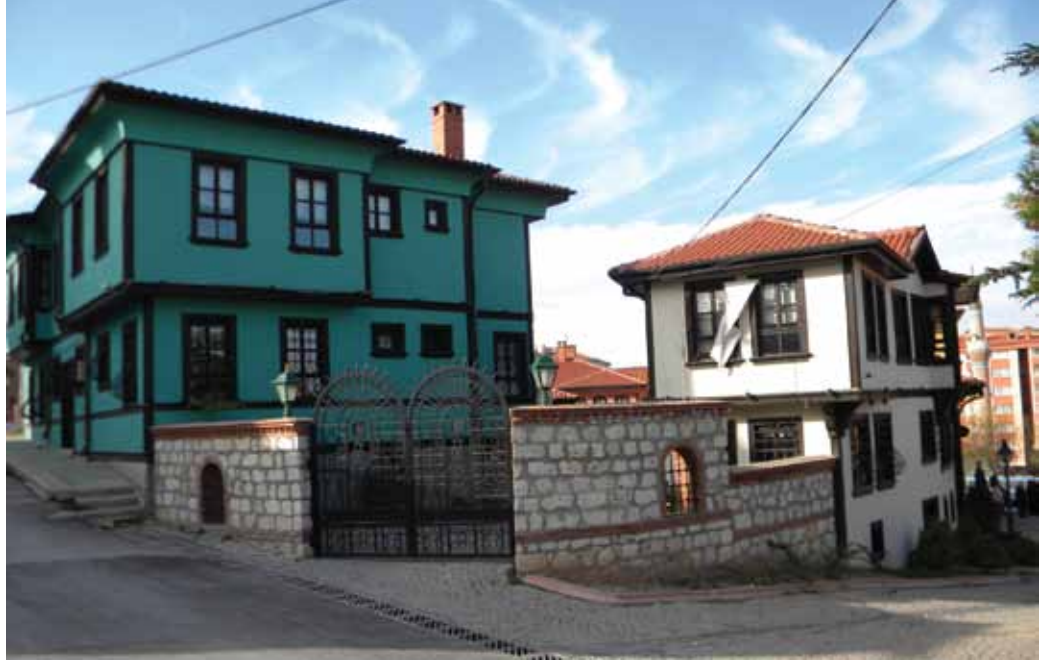
Resim 3. Eskişehir Odunpazarı Belediyesi'nin tarihi evlerine benzeterek inşa ettiği yeni yapılar (Fotoğraf: Duygu Saban Ökesli)
