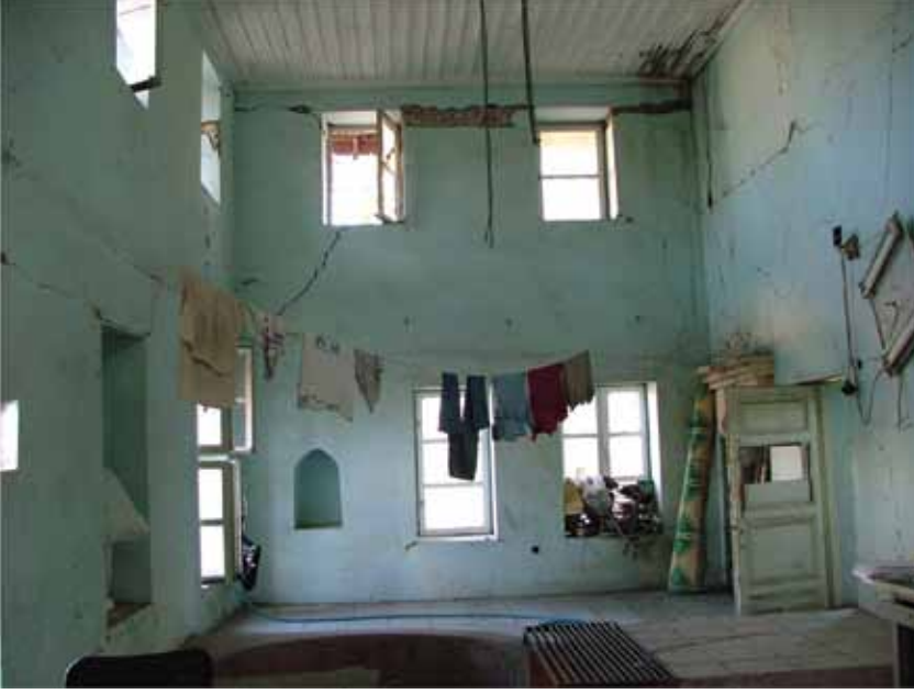
Resim 5. Restorasyon Öncesinde Konak İç Mekan
