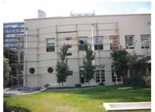
Resim 12. Başkanlık giriş merdivenin doğu tarafındaki duvarda ortaya çıkarılan dışarıdan kapatılmış dairesel pencereler (foto: Oğuz Ergeç)
