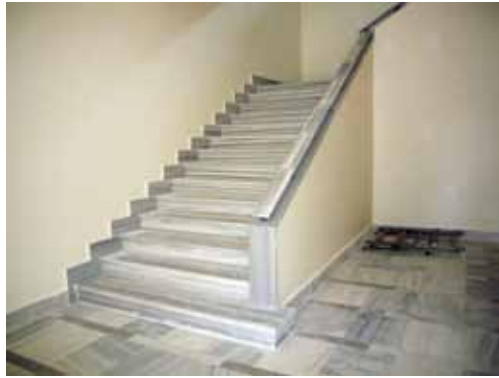
Resim 9a-b. Restore edilen ve özgün mermer küpeşterleri monte edilen merdiven (foto: Oğuz Ergeç)
