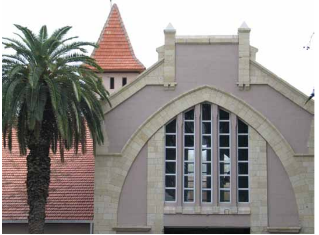
Resim 12. Satış holü cephesi ve su kulesi (Akar, 2005)
