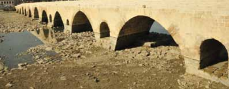
Şekil 14. Restorasyon sonrası mansap görünüşü (2007).
