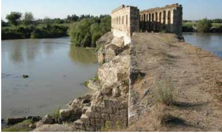
Şekil 35. Akdeğirmen Köprüsü, Değirmen Girişi.
