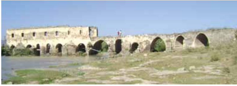
Şekil 33. Akdeğirmen Köprüsünün Menbadan Genel Görünümü.
