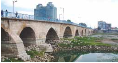
Şekil 12. Restorasyon öncesi mansap görünüşü (2006).
