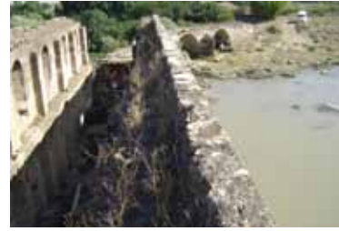
Şekil 36. Akdeğirmen Köprüsü / Üst Görünüş.
