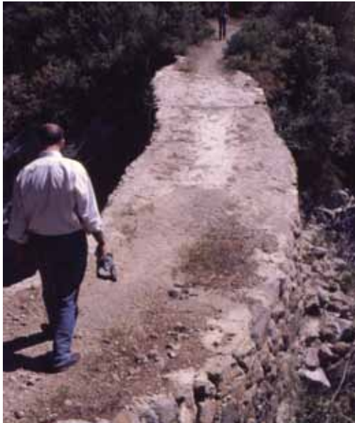
Şekil 47. Seldiren Köprüsü / Yol.
