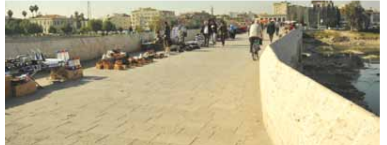
Şekil 15. Restorasyon sonrası köprü.
