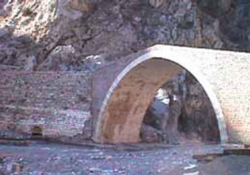
Şekil 53. Akköprü Rekonstrüksiyon Sonrası Mansap Görünüşü.
