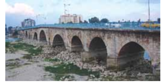
Şekil 13. Restorasyon öncesi menba görünüşü (2006).
