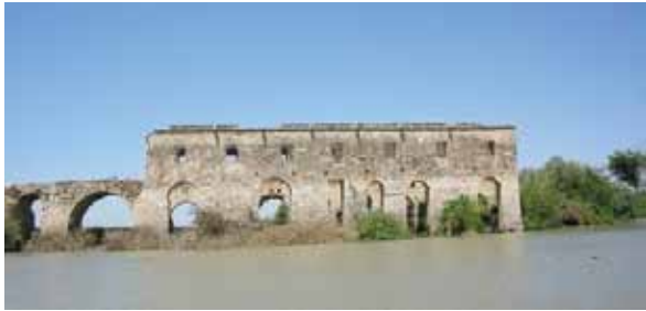
Şekil 38. Akdeğirmen Köprüsü / Mansap.
