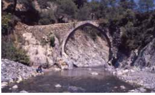
Şekil 45. Seldiren Köprüsü Mansap Görünüşü.
