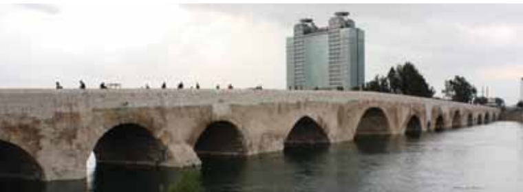
Şekil 16. Restorasyon sonrası mansap görünüşü.
