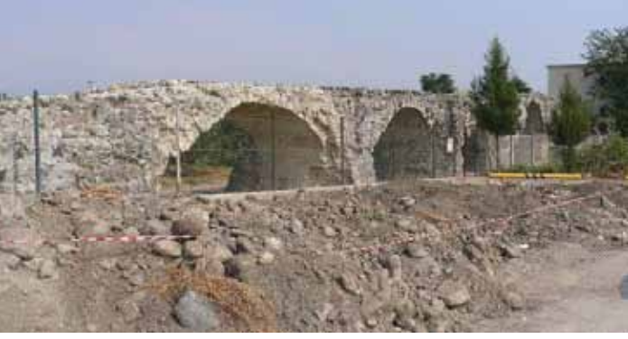
Şekil 23. Kinet Köprüsü Görünüş (2005).
