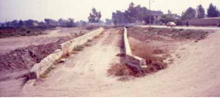
Şekil 10. Tarsus Justinyen Köprüsü 2003 yılındaki durumu.
