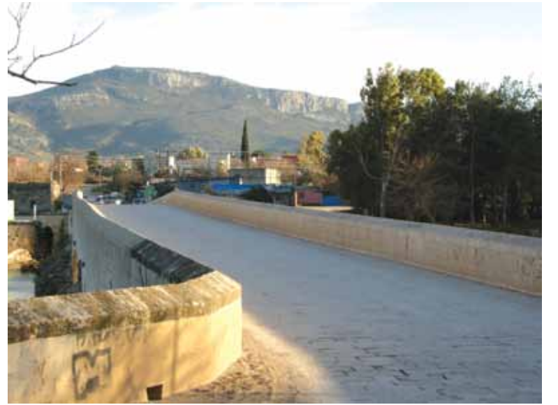
Şekil 21. Misis Köprüsü Bugünkü Görünüşü.
