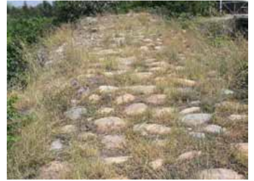
Şekil 29. Payas Köprüsü Üst Görünüş.
