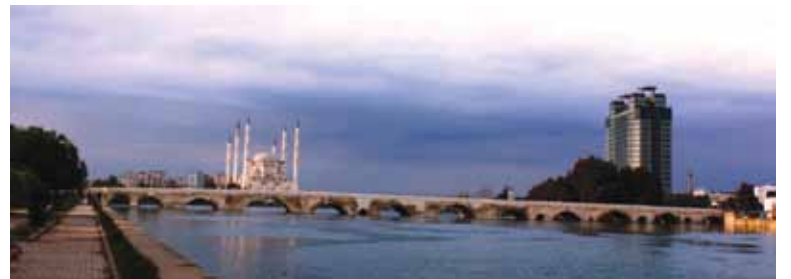
Şekil 17. Köprünün genel görünüşü (2008).
