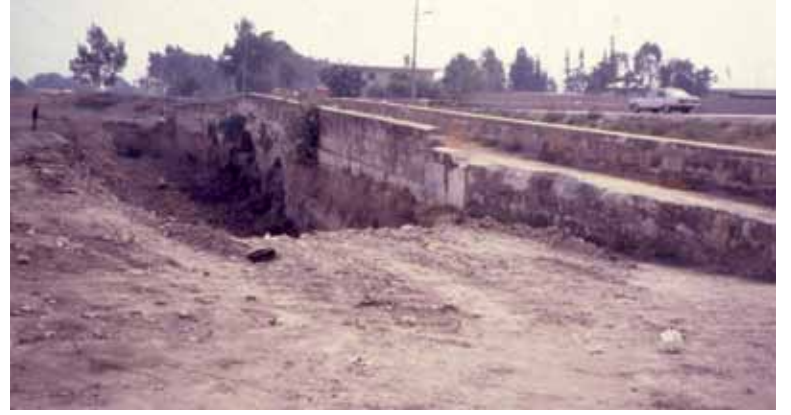
Şekil 9. Tarsus Justinyen Köprüsü 2003 yılındaki durumu.
