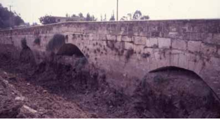
Şekil 8. Tarsus Justinyen Köprüsü 2003 yılındaki durumu.
