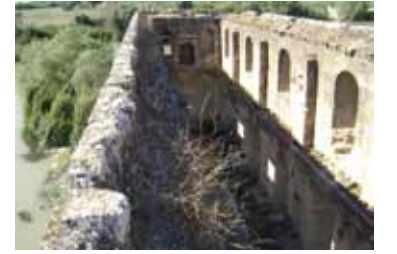
Şekil 37. Akdeğirmen Köprüsü / Üst Görünüş.
