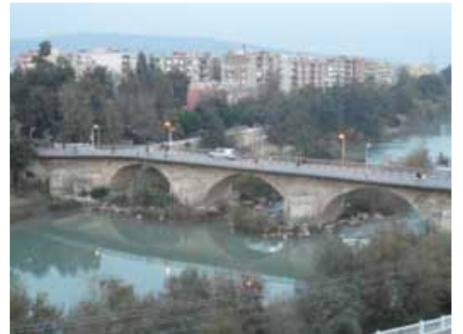
Şekil 7. Silifke Taş Köprü'nün bugünkü durumu.
