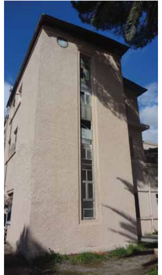
Resim 5. Dikey merdiven penceresi.
