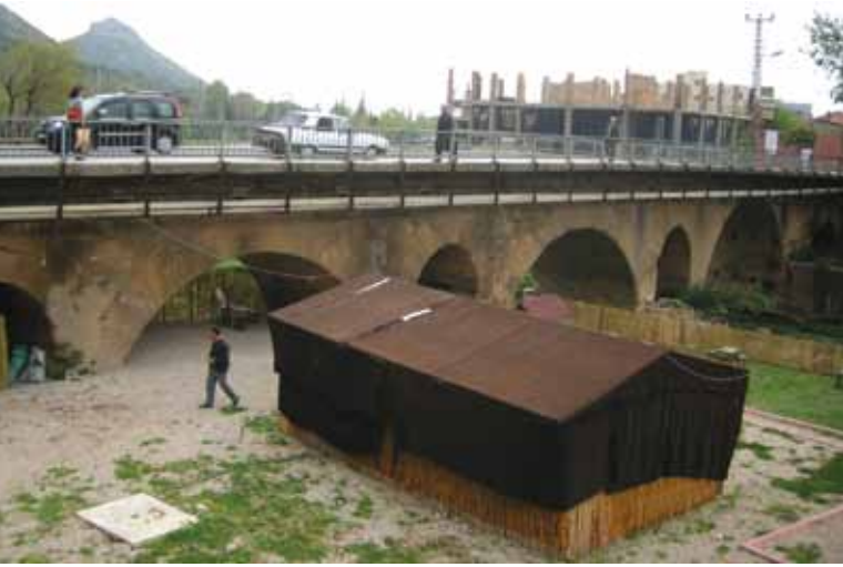
Şekil 42. Kozan Köprüsü / Menba (2012).
