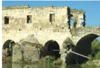
Şekil 39. Akdeğirmen Köprüsü Ayaklar / Menba.
