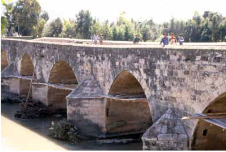
Şekil 18. Misis Köprüsü Restorasyon Sırasında Köprü'nün Menba Görünüşü (1998).
