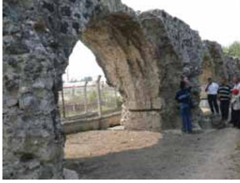
Şekil 24. Kinet Köprüsü Kemerleri (2005).
