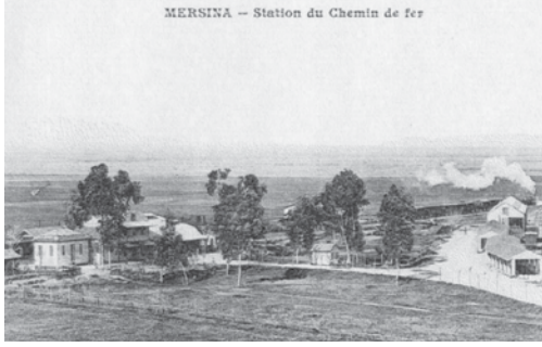
Şekil 11. Mersin Eski İstasyon Binası (Ali Murat Merzeci Aşv.).
