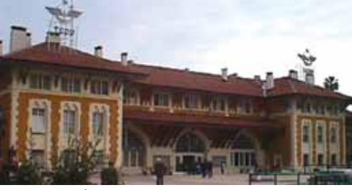
Şekil 17. Adana İstasyon Binası.
