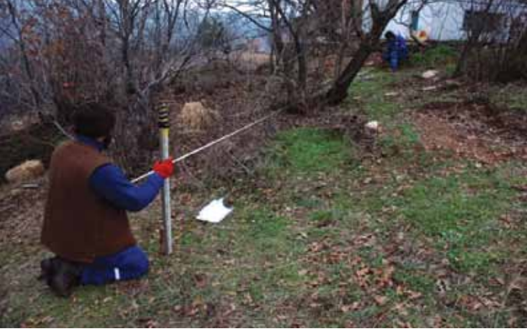
Şekil 3. Ahşap Bungalow Yapımına Katılım (Url-6, E.T.: 17.05.2015).
