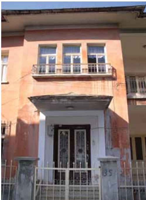
Resim 7. Merdiven holünün giriş cephesine yansıması.
