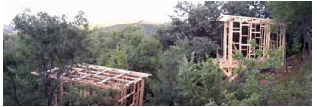
Şekil 2. Ahşap Bungalov Yapımı (Url-6, E.T.: 17.05.2015).
