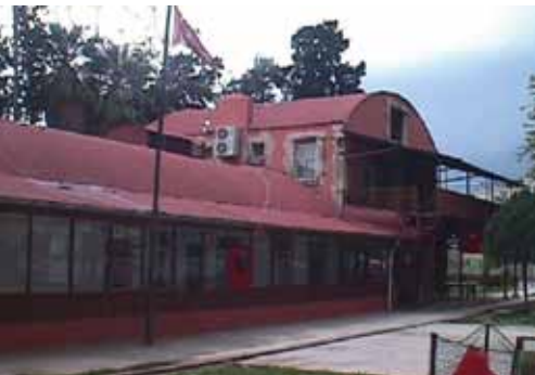
Şekil 10. a-b-c) Adana Eski İstasyon Binası.
