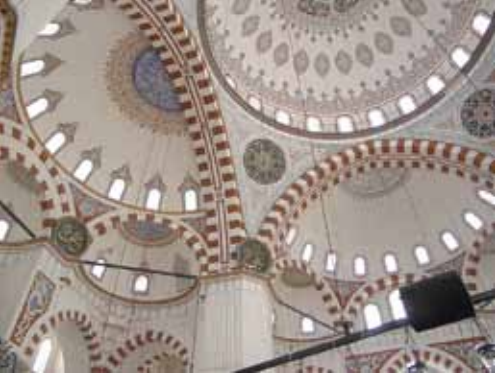
Resim 3. Şehzade Camisi Kubbe Geçişleri Sistemi.
