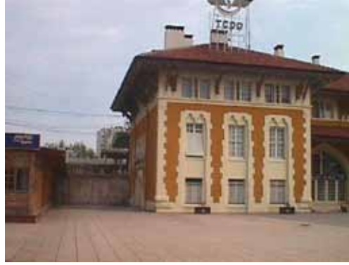
Şekil 19. b) Ön Cephe.
