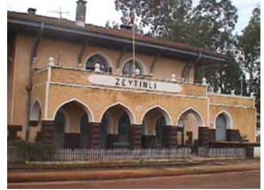
Şekil 21. a) Zeytinli İstasyon Binası.
